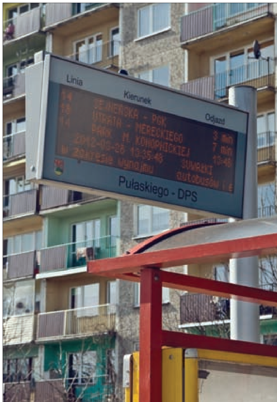
Elektroniczna tablica informacyjna, element zmodernizowanego systemu transportu miejskiego w Suwałkach An electronic information board, an element of the modern city transportation system in Suwalki
