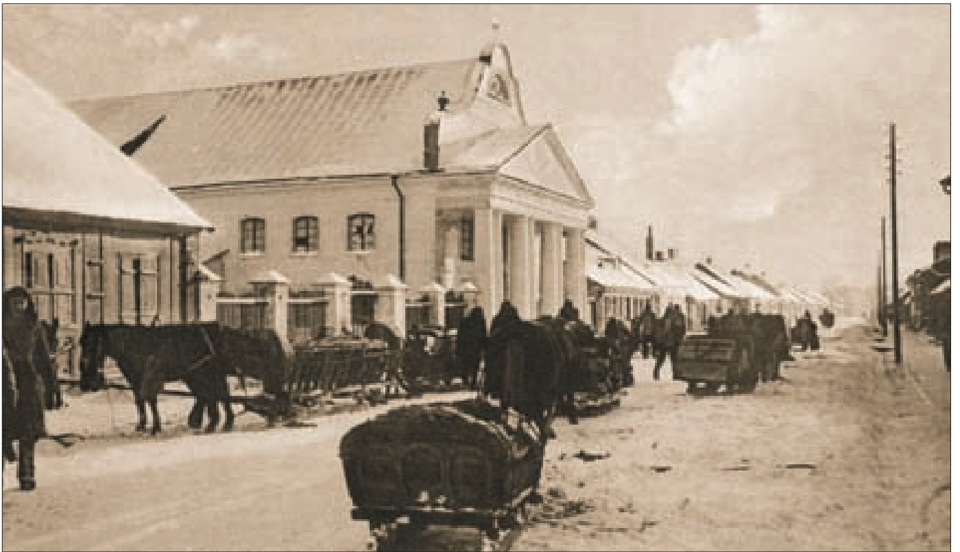
Synagoga Główna w Suwałkach, rozebrana w 1956 r., obecnie ul. Noniewiczza i teren Osiedla II
