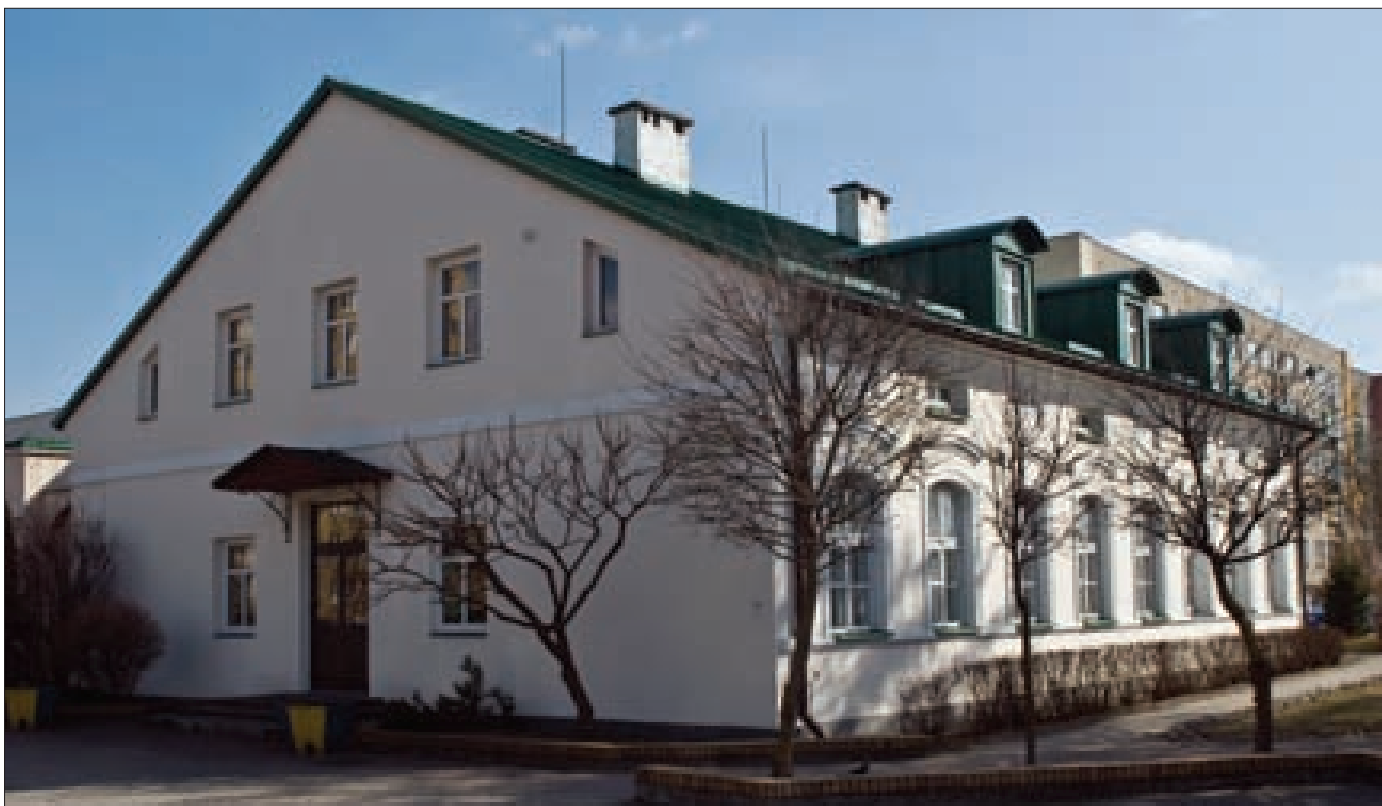
Po remoncie, siedziba Młodzieżowego Domu Kultury w Suwałkach After renovation, Youth Center of Culture in Suwałki
