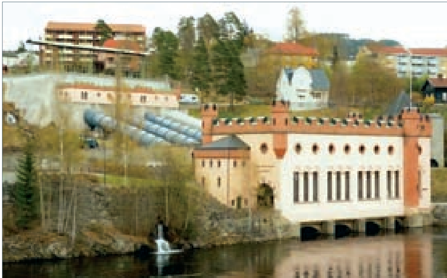
“Borgen” Power Plant (1912). “Borgen” Kraftstasjon (1912). Elektrownia wodna Borgen (1912 r.).
